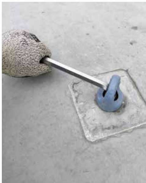
Abb. 4 Der Anschlagpunkt muss festgezogen und dennoch frei drehbar sein.
