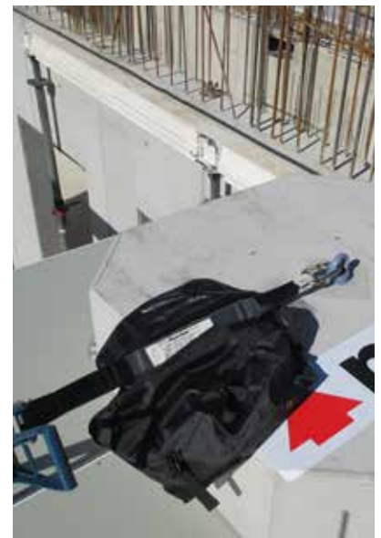
Abb. 5 Mit min. 250 bis max. 500 daN vorspannen.
