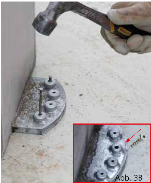
Abb. 3 Je 2 Stk. 60-70 mm lange Stahlnägel mit Durchmesser 2 mm pro Ecke einschlagen, oder je eine Schraube 6 mm x min. 40 mm.
